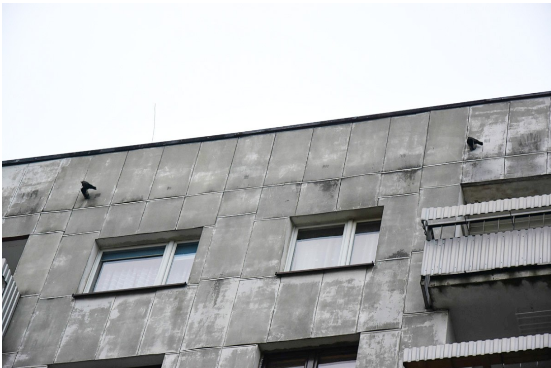
Fot.14. Widok części stropowej budynku od strony południowej. Na rurach widoczne są kawki (aut. Szymon Wójcik)
