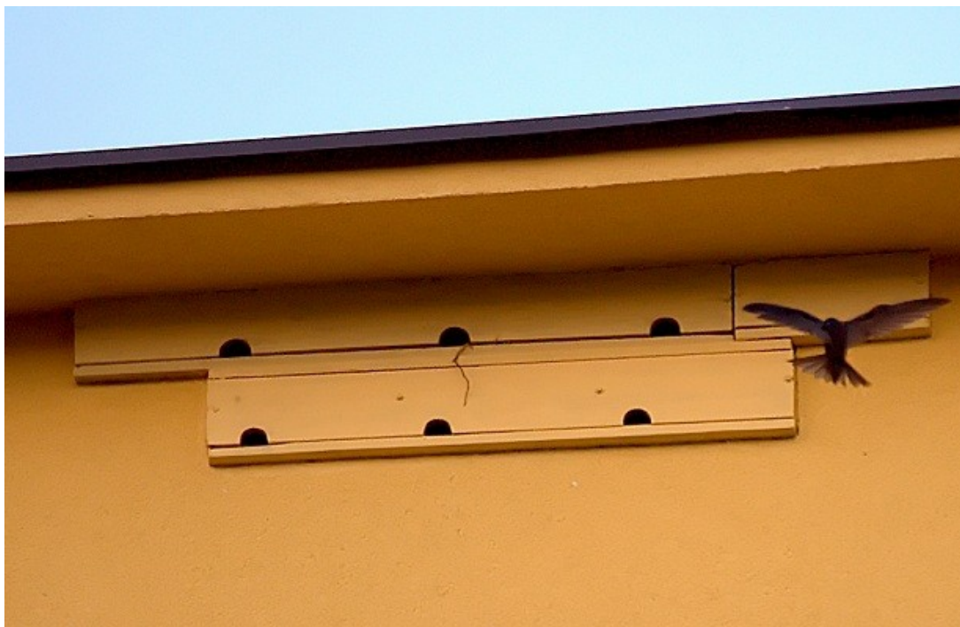
Fot. 27. Efekt końcowy – budka dla jerzyka Apus apus otoczona styropianem (aut. Szymon Wójcik)
