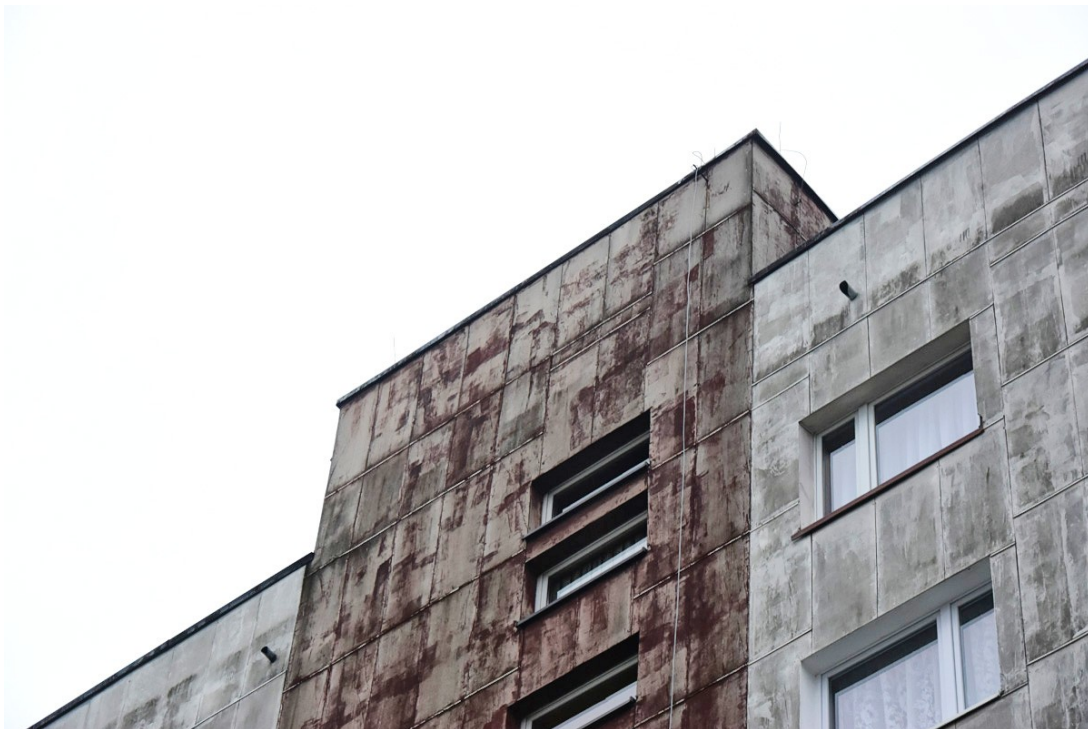
Fot.9. Widok części stropowej od strony północnej (aut. Szymon Wójcik)
