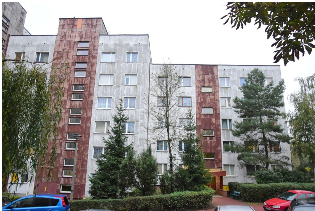
Fot.1. Widok ściany budynku od strony północnej (aut. Szymon Wójcik)
