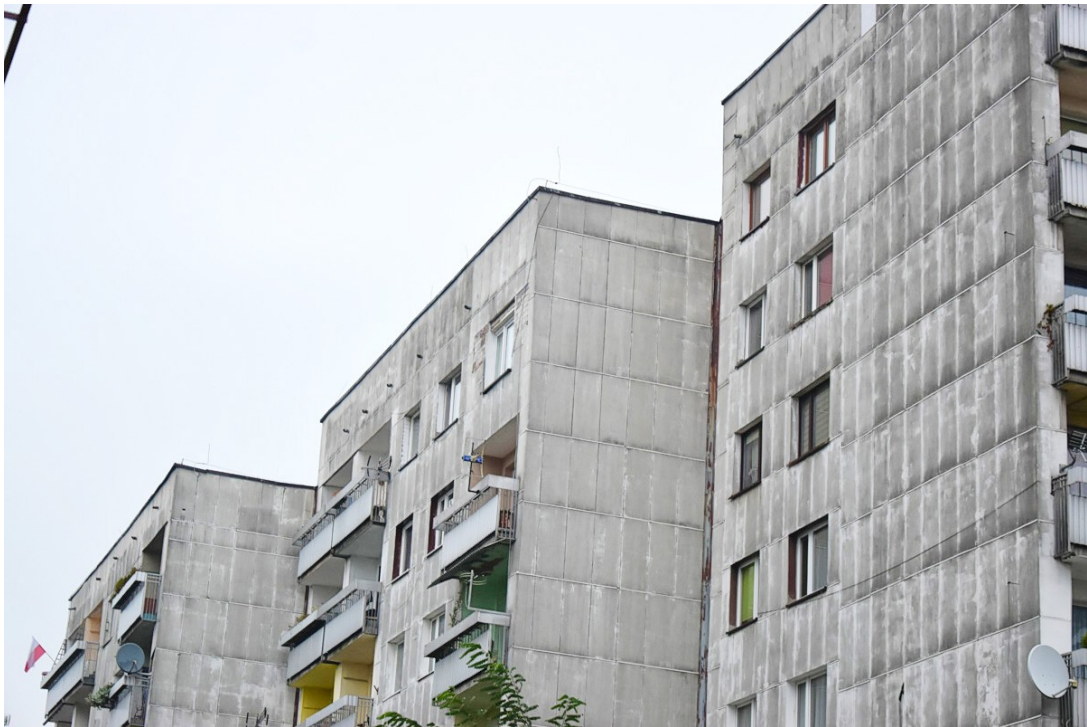
Fot.18. Widok części stropowej od strony zachodniej (aut. Szymon Wójcik)
