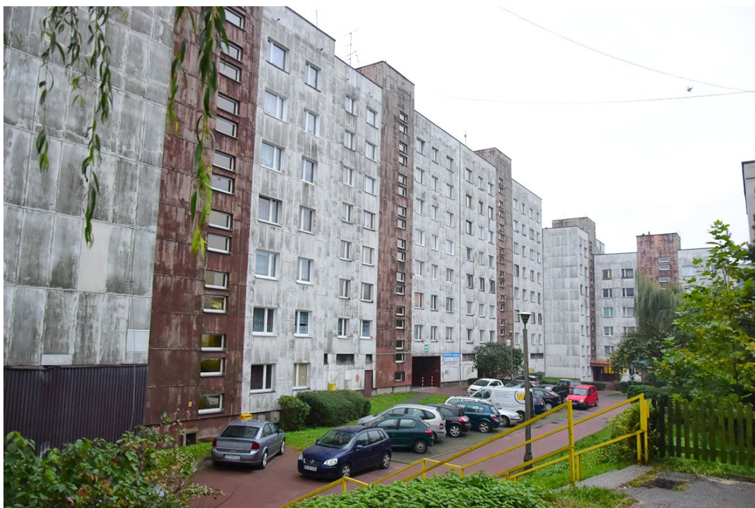
Fot.10. Widok budynku od strony północnej (aut. Szymon Wójcik)
