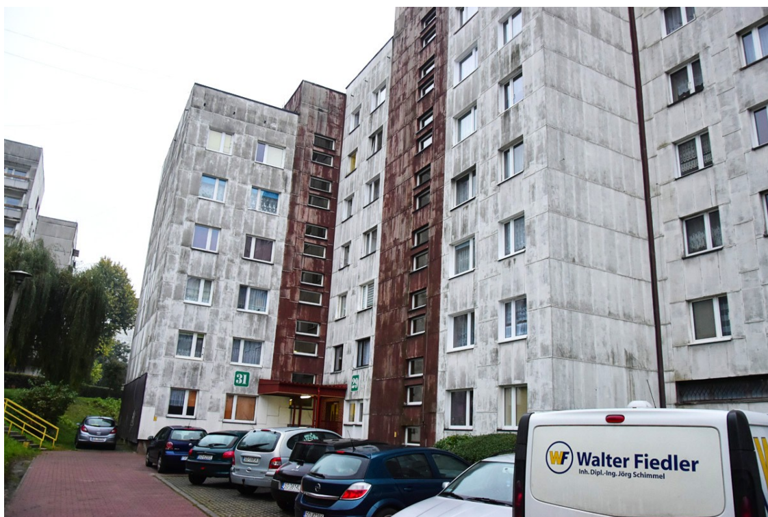
Fot.8. Widok budynku od strony północnej (aut. Szymon Wójcik)
