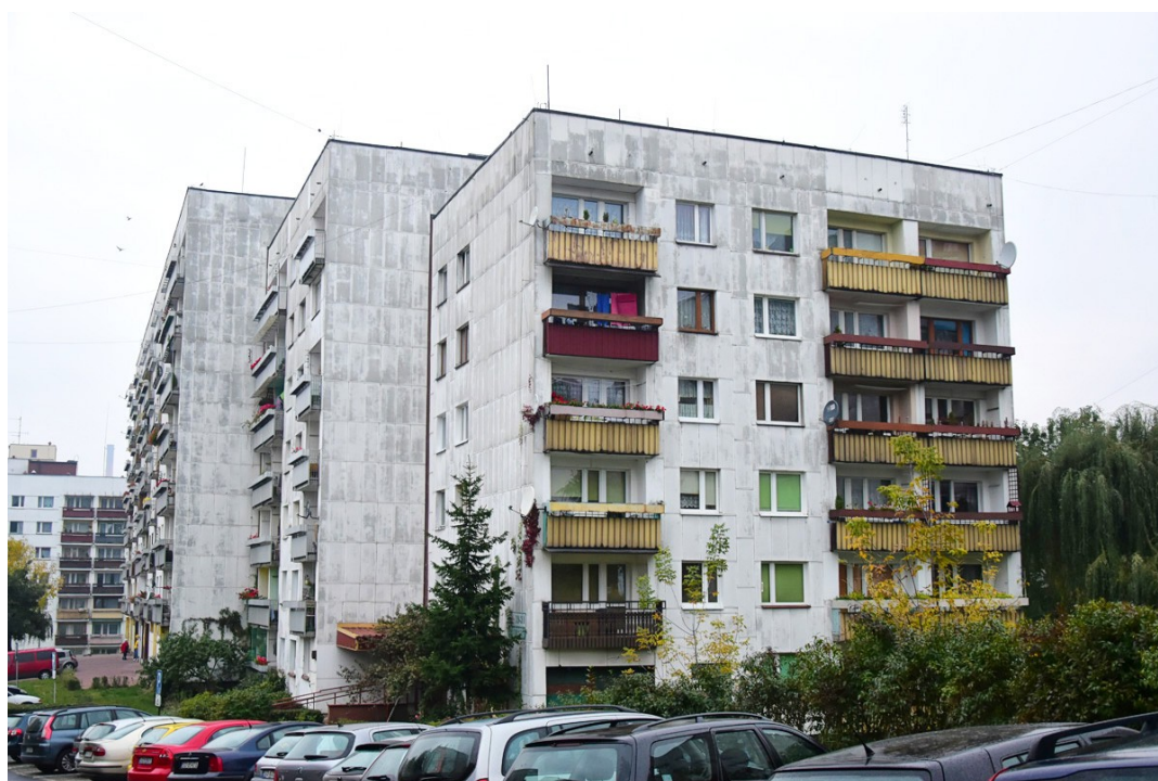
Fot.12 Widok budynku od strony wschodniej (aut. Szymon Wójcik)
