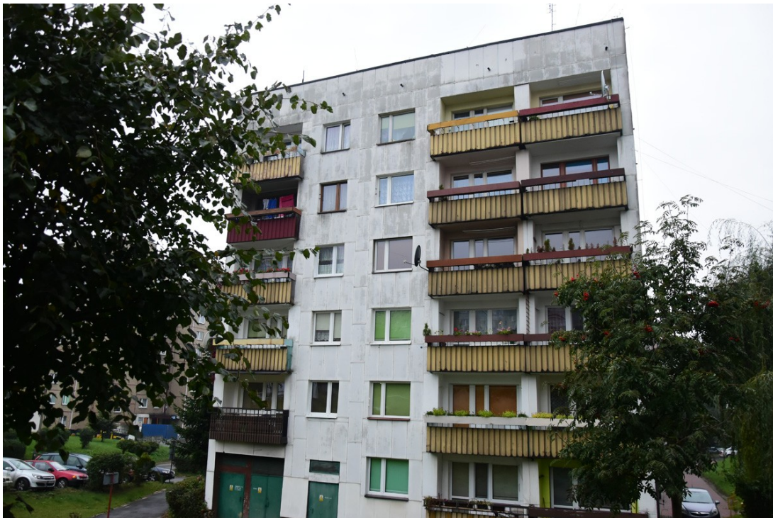
Fot.11. Widok budynku od strony wschodniej (aut. Szymon Wójcik)
