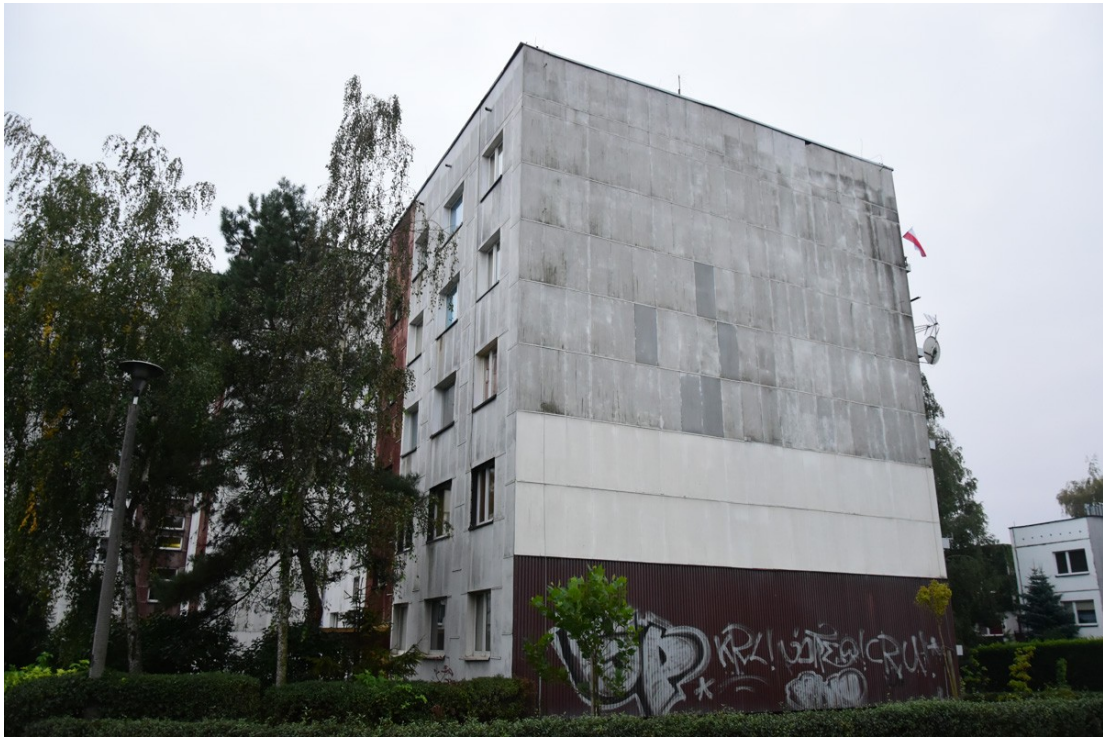
Fot.3. Widok budynku od strony północnej (aut. Szymon Wójcik)
