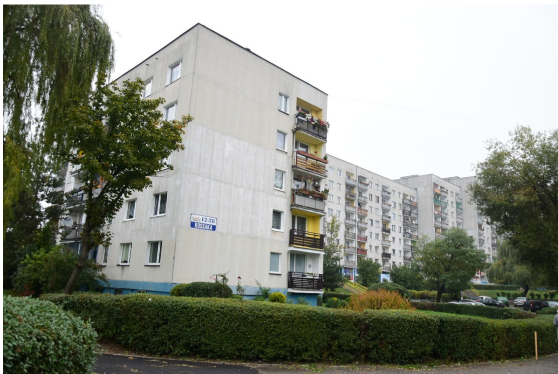
Fot.1. Widok budynku od strony pd-zach (aut. Szymon Wójcik)
