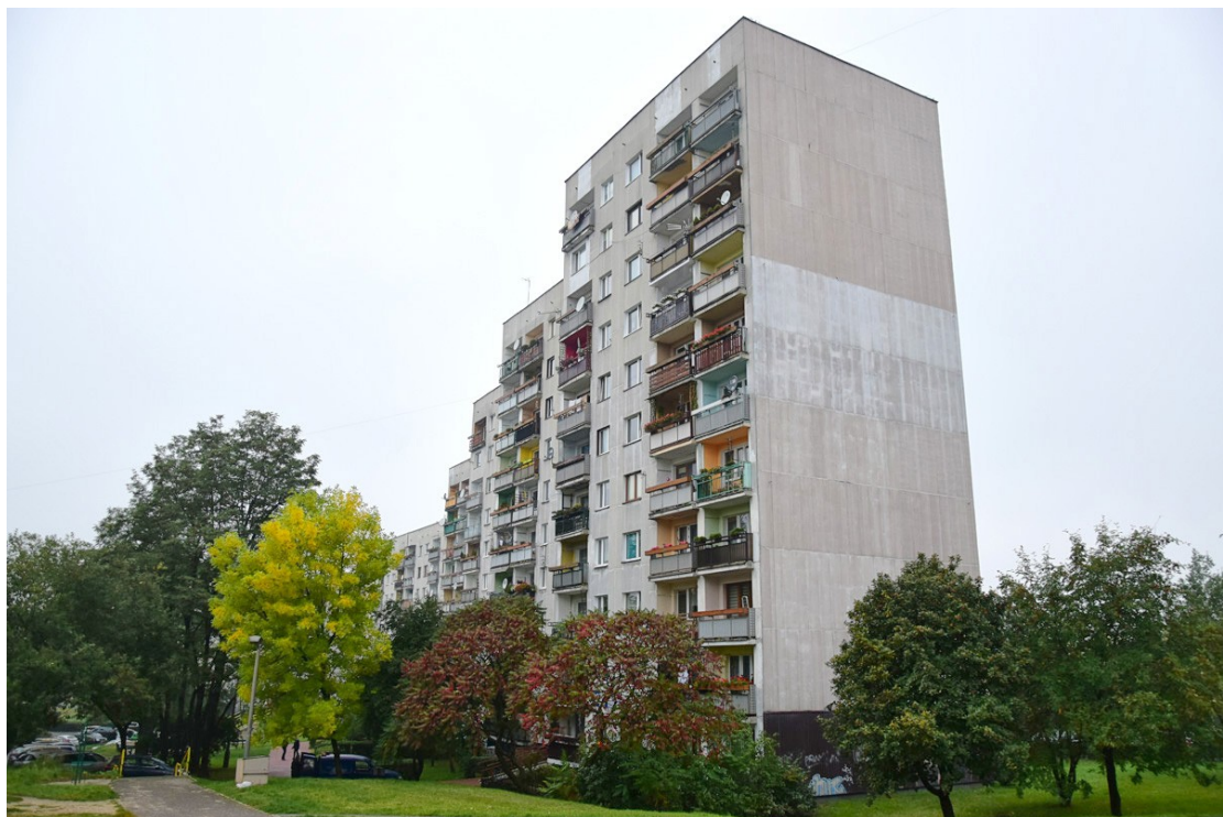
Fot.9. Widok budynku od strony pd-wsch (aut. Szymon Wójcik)
