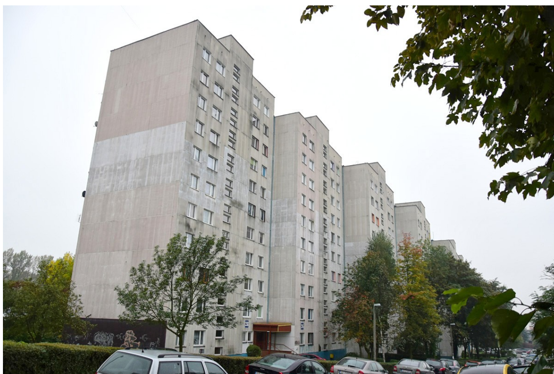
Fot.11. Widok budynku od strony pn-wsch (aut. Szymon Wójcik)
