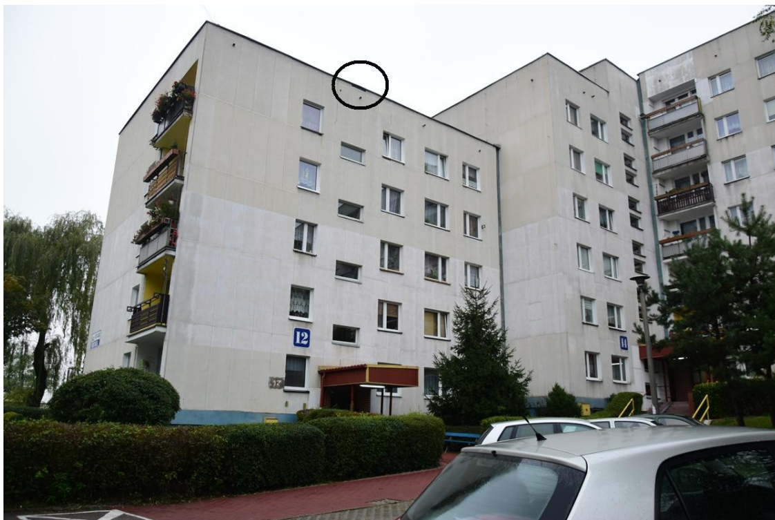
Fot.2. Widok budynku od strony pd-wsch (aut. Szymon Wójcik)
