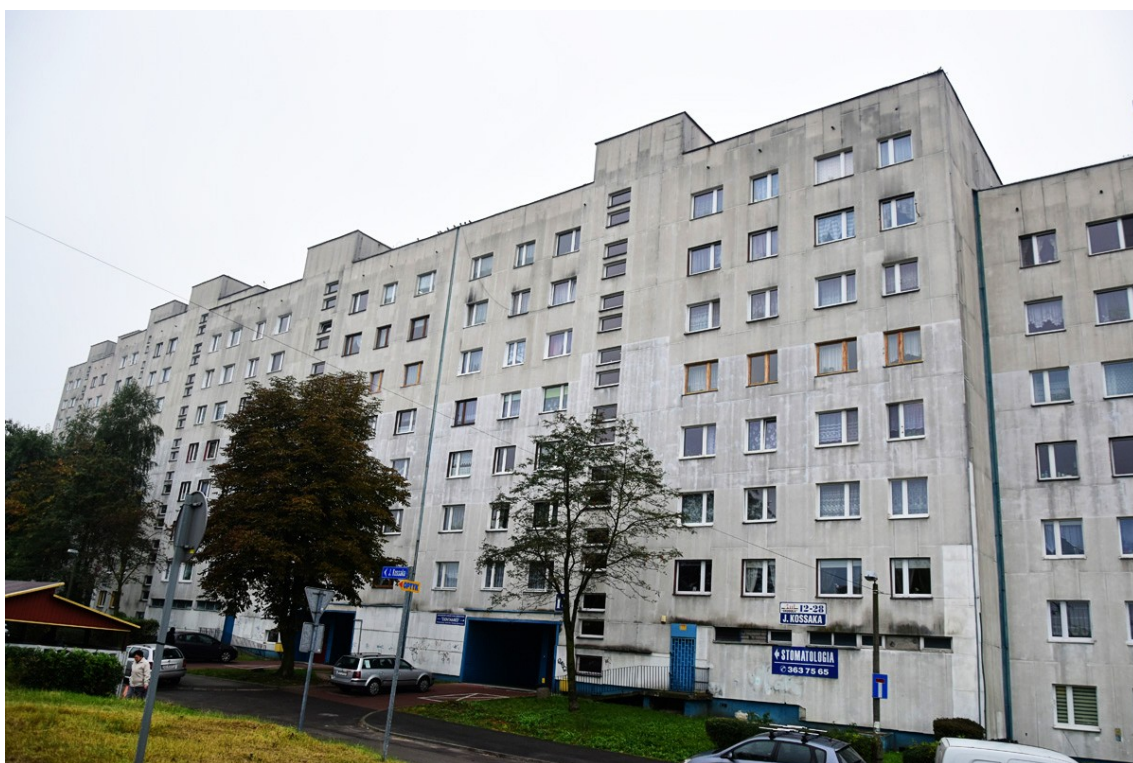
Fot.16. Widok budynku od strony północnej (aut. Szymon Wójcik)
