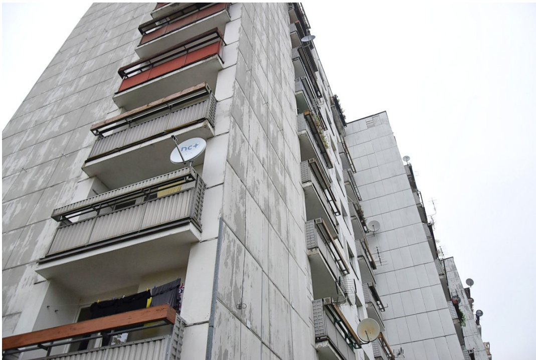
Fot.19. Widok budynku od strony pn-wsch (aut. Szymon Wójcik)
