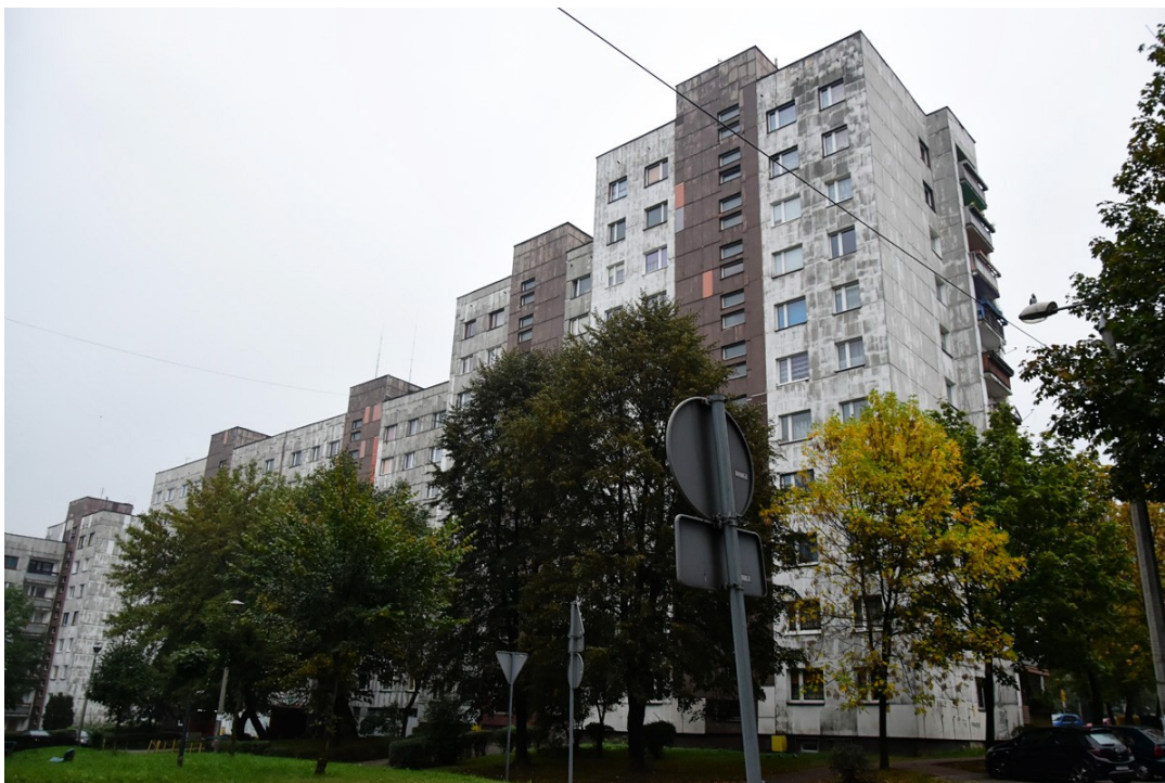
Fot.1. Widok budynku od strony zachodniej (aut. Szymon Wójcik)
