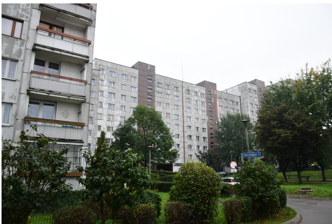
Fot.12. Widok budynku od strony zachodniej (aut. Szymon Wójcik)
