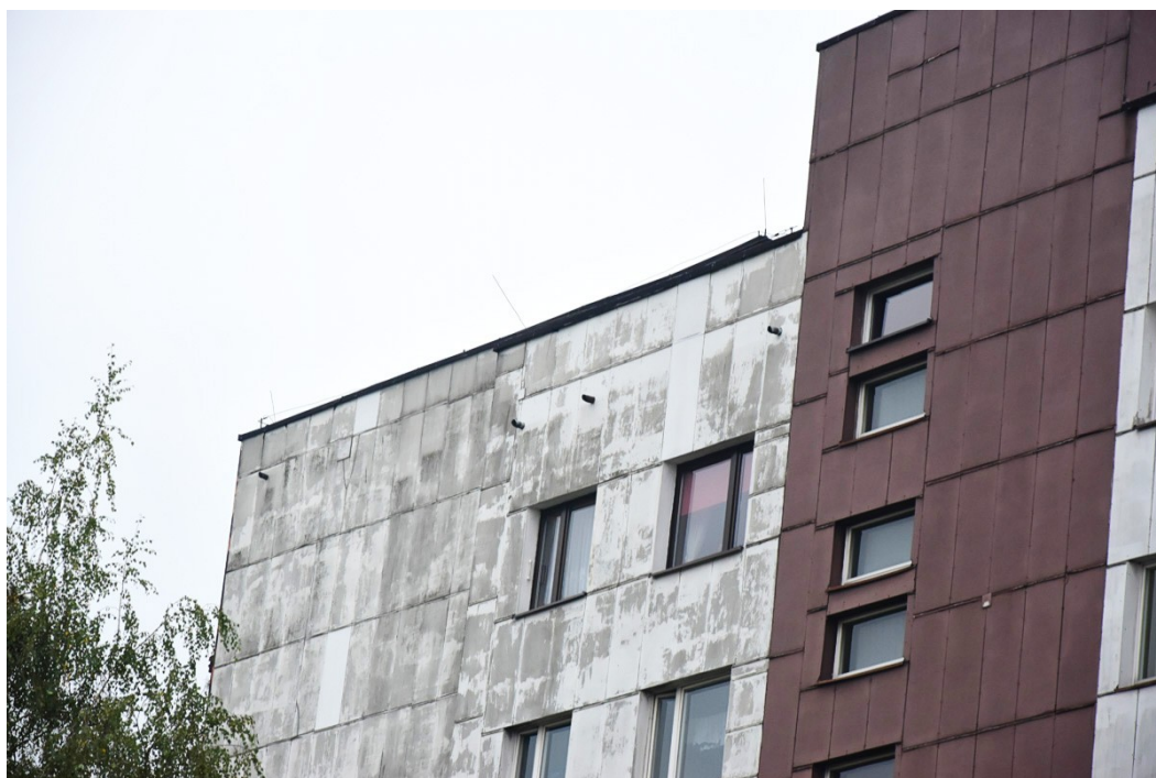
Fot.14. Widok części stropowej budynku od strony północnej (aut. Szymon Wójcik)
