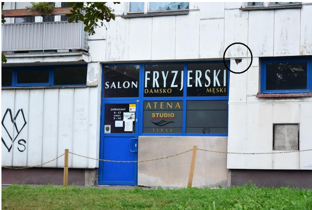
Fot.17. Widok ściany wschodniej. Okręgiem oznaczono wyraźny ubytek, który może być zasiedlony przez wróbla, szpaka lub sikory (aut. Szymon Wójcik)
