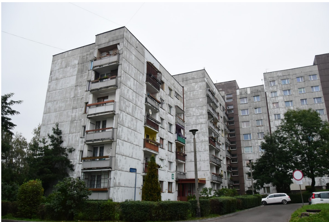
Fot.11. Widok budynku od strony zachodniej (aut. Szymon Wójcik)
