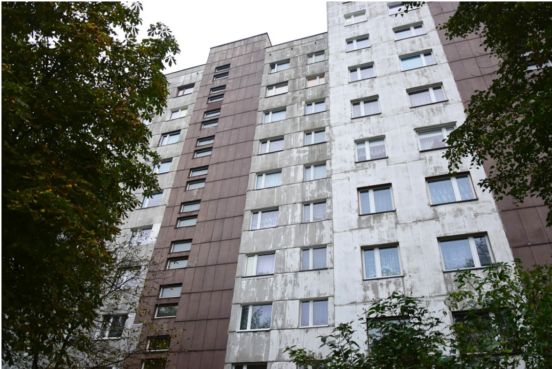
Fot.7. Widok budynku od strony zachodniej (aut. Szymon Wójcik)
