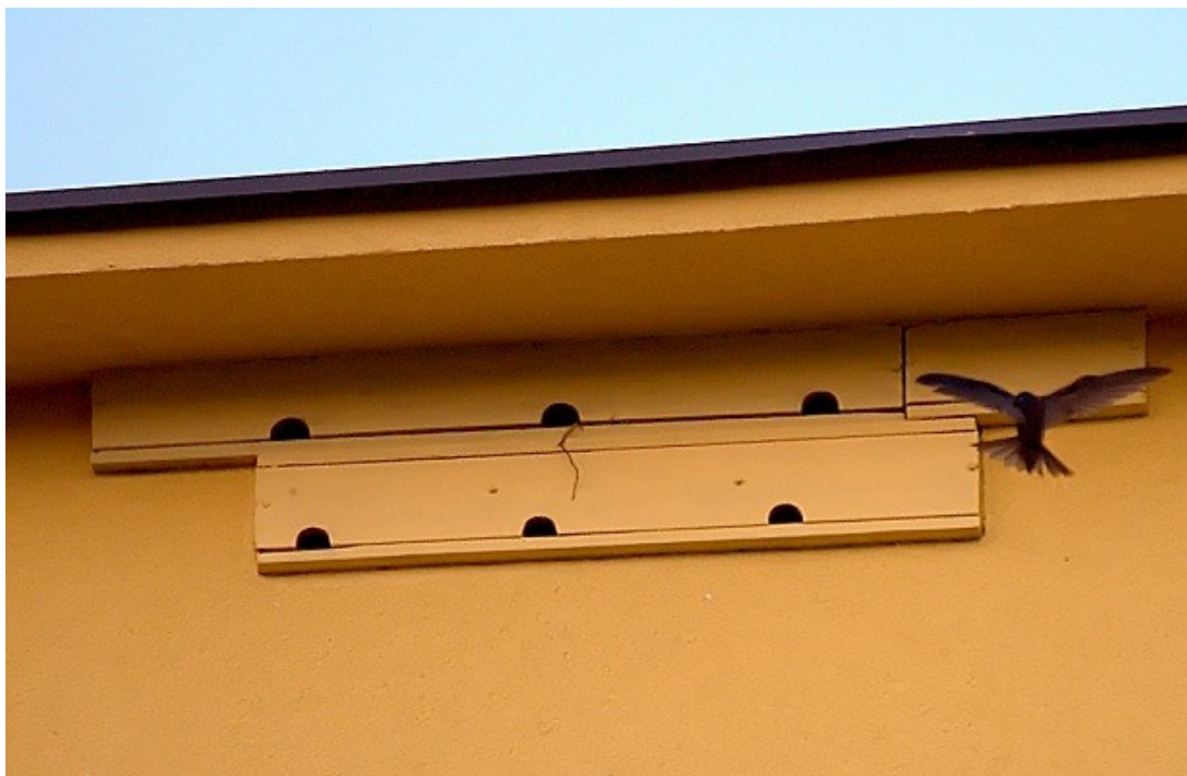
Fot. 25. Efekt końcowy – budka dla jerzyka Apus apus otoczona styropianem (aut. Szymon Wójcik)
