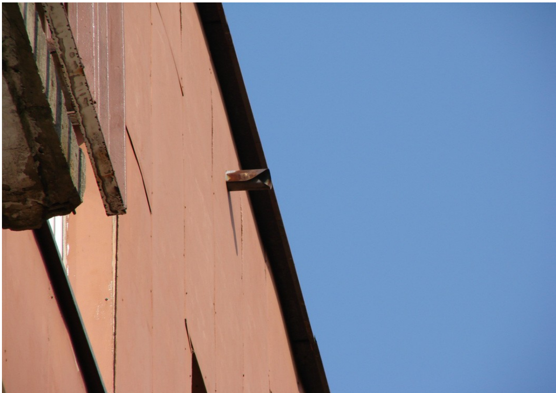
Fot.5. Widok części stropowej od strony zachodniej (aut. Szymon Wójcik)
