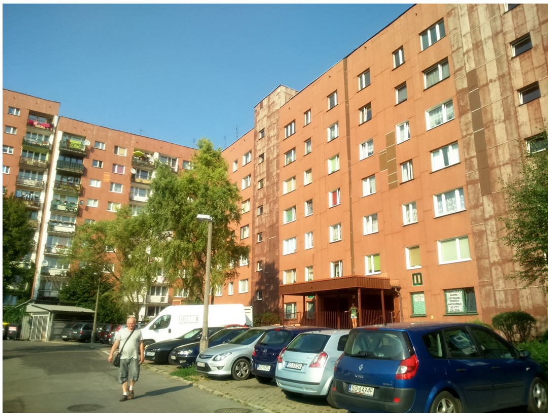
Fot.9. Widok budynku od strony zachodniej (aut. Szymon Wójcik)
