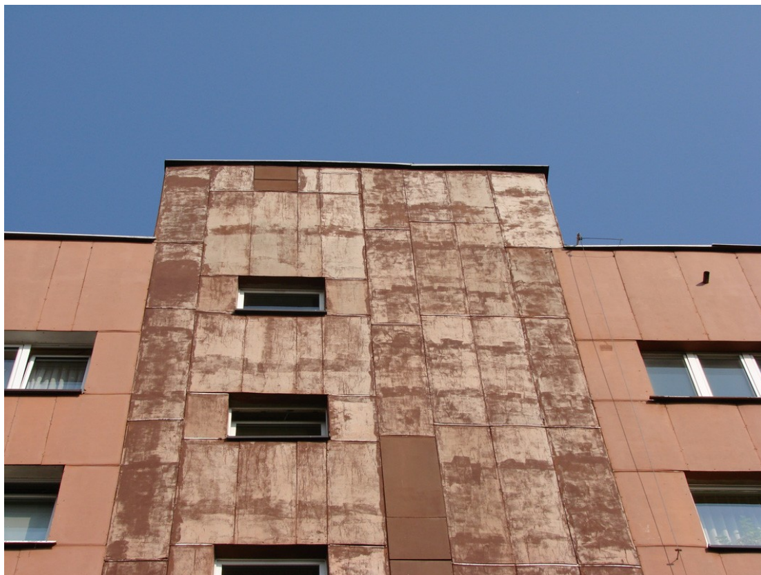
Fot.7. Widok części stropowej od strony zachodniej (aut. Szymon Wójcik)
