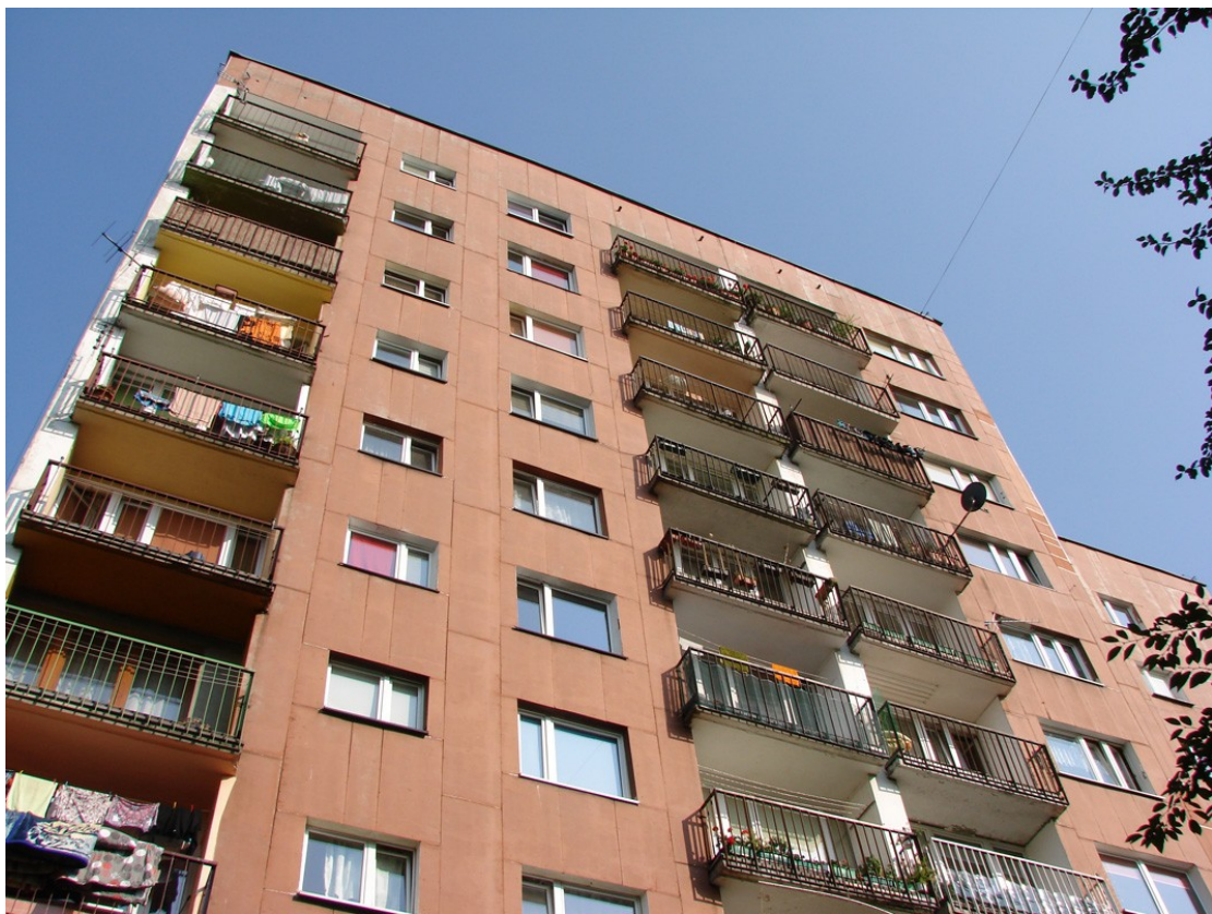
Fot.14. Widok ściany budynku od strony zachodniej (aut. Szymon Wójcik)
