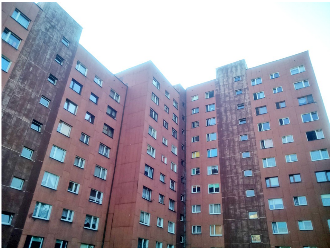
Fot.16. Widok budynku od strony wschodniej (aut. Szymon Wójcik)
