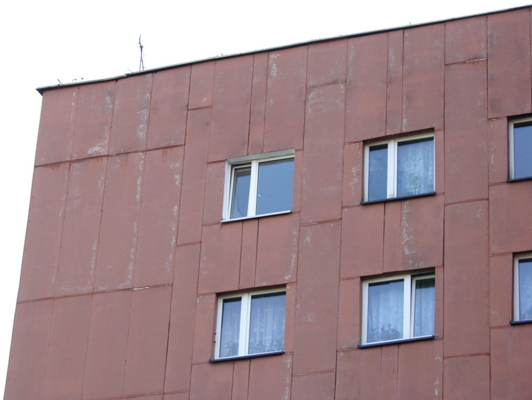
Fot.20. Widok części stropowej budynku od strony wschodniej (aut. Szymon Wójcik)
