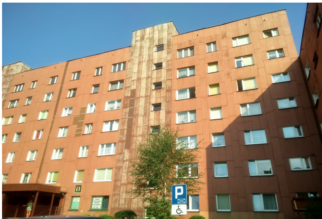
Fot.2. Widok budynku od strony zachodniej (aut. Szymon Wójcik)
