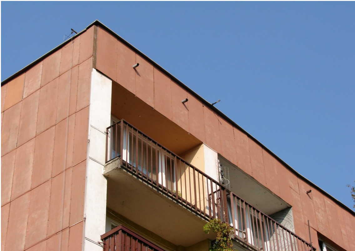
Fot.3. Widok części stropowej od strony południowej (aut. Szymon Wójcik)
