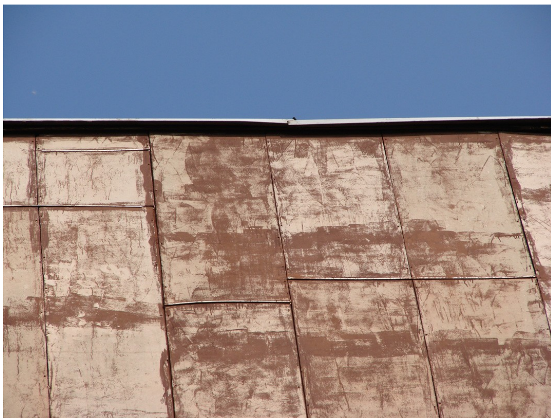
Fot.8. Widok części stropowej od strony zachodniej (aut. Szymon Wójcik)
