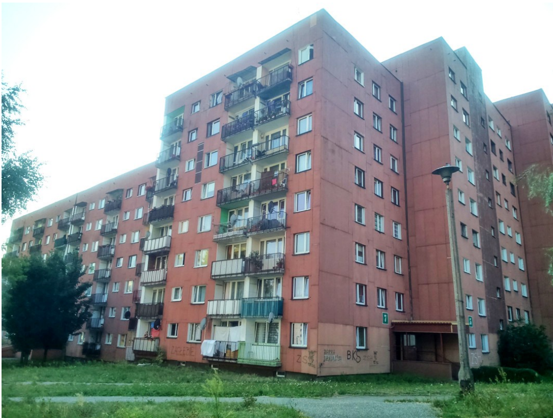
Fot.15. Widok budynku od strony wschodniej (aut. Szymon Wójcik)
