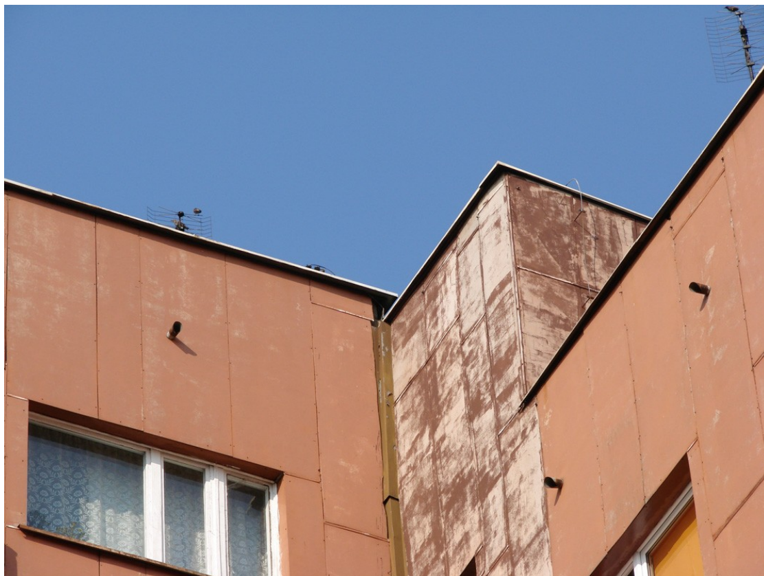
Fot.11. Widok części stropowej budynku od strony zachodniej (aut. Szymon Wójcik)
