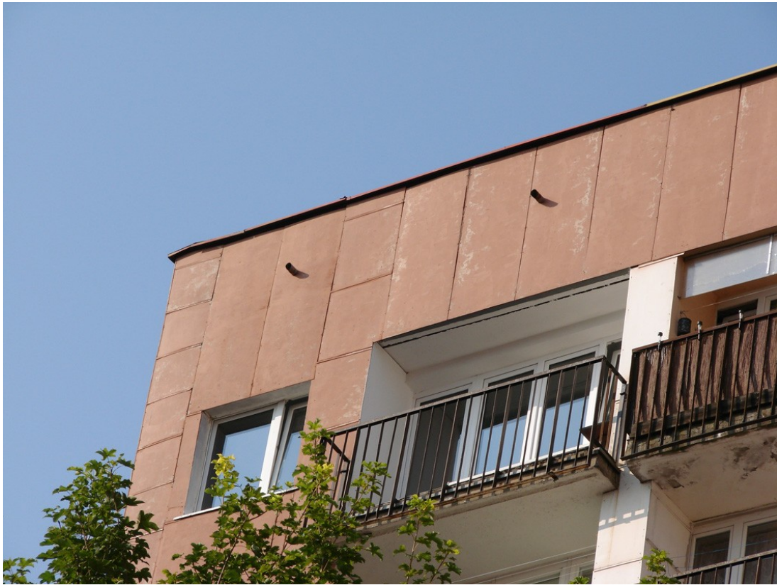
Fot.13. Widok części stropowej budynku od strony zachodniej (aut. Szymon Wójcik)
