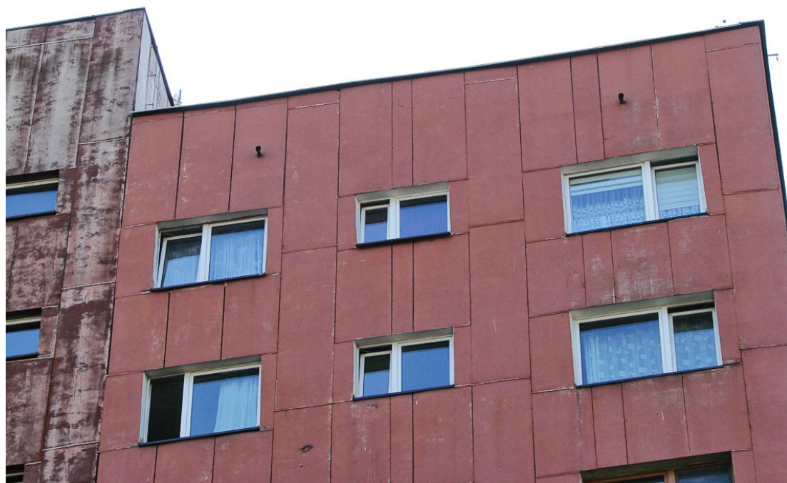
Fot.18. Widok części stropowej budynku od strony wschodniej (aut. Szymon Wójcik)
