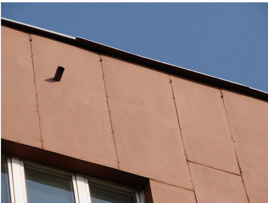
Fot.6. Widok części stropowej od strony zachodniej (aut. Szymon Wójcik)
