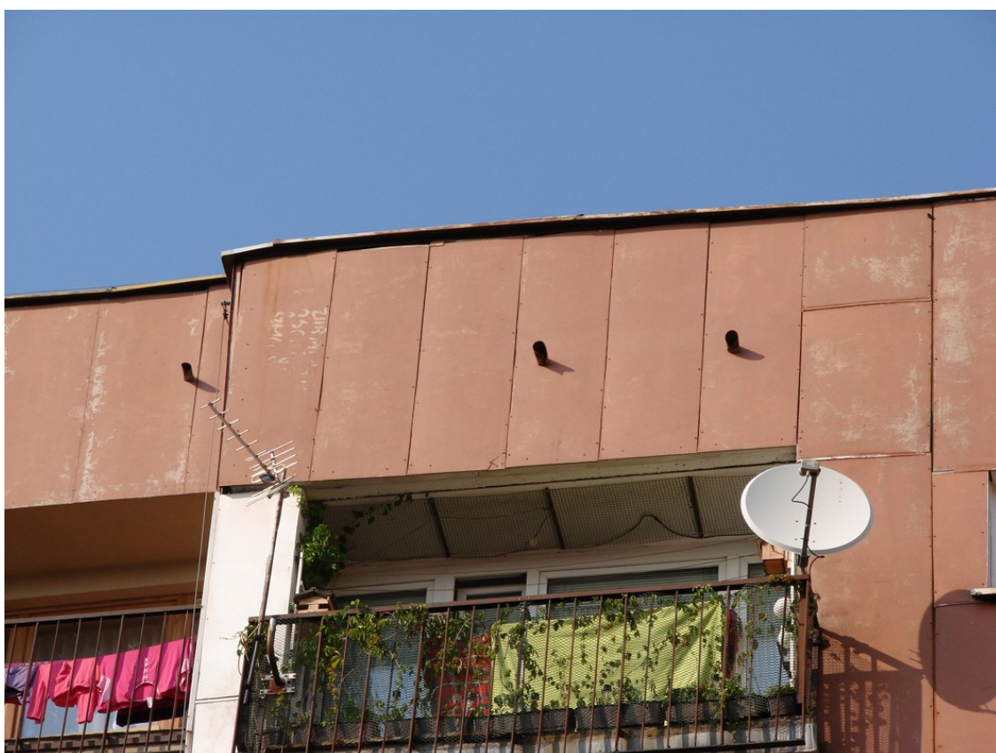
Fot.12. Widok części stropowej budynku od strony zachodniej (aut. Szymon Wójcik)
