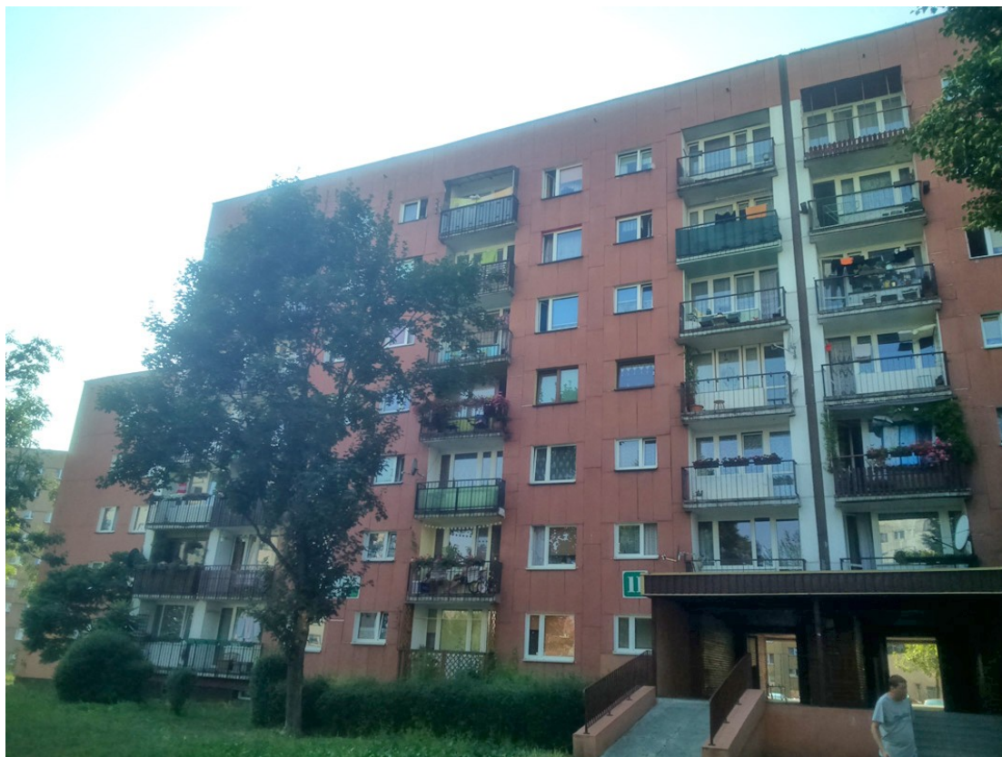
Fot.17. Widok budynku od strony wschodniej (aut. Szymon Wójcik)
