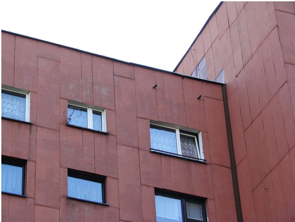
Fot.19. Widok części stropowej budynku od strony wschodniej (aut. Szymon Wójcik)
