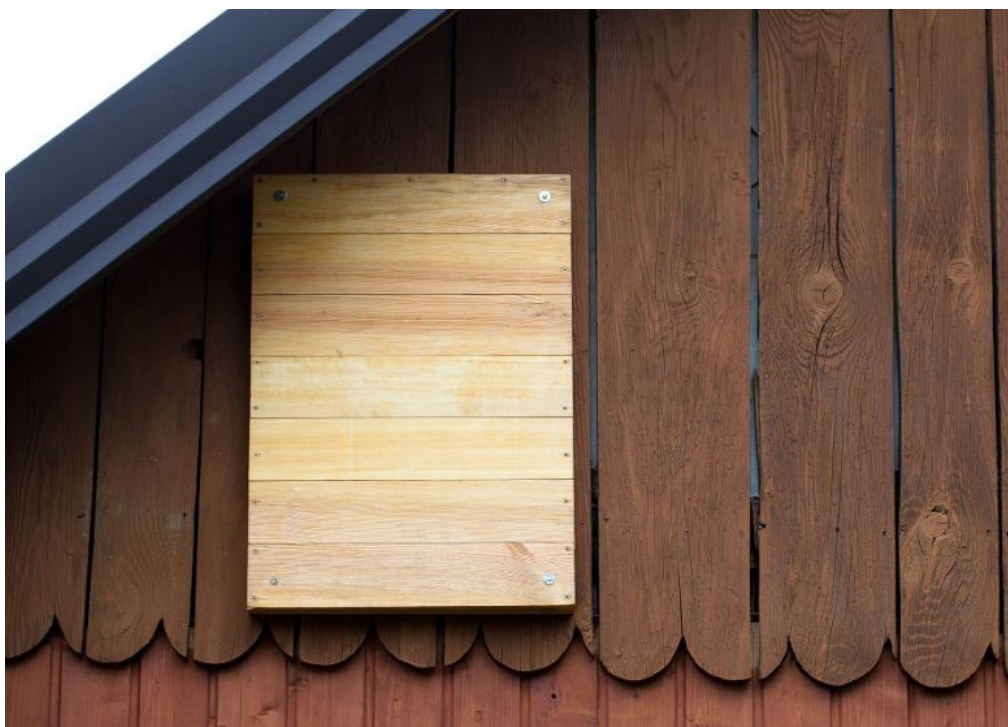
Fot.27. Przykładowa budka natynkowa. Po zamocowaniu budki należy ją pokryć styropianem zostawiając otwór wlotowy (aut. Szymon Wójcik).
