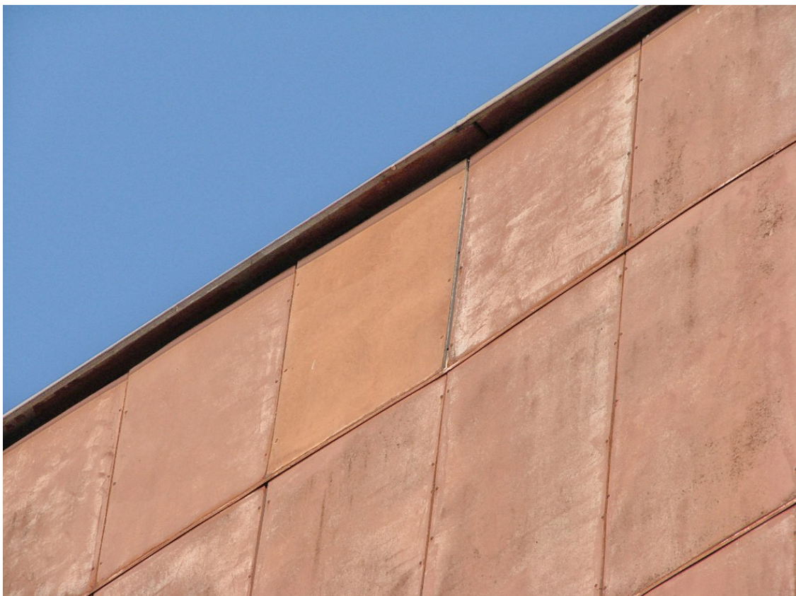
Fot.4. Widok części stropowej od strony zachodniej (aut. Szymon Wójcik)
