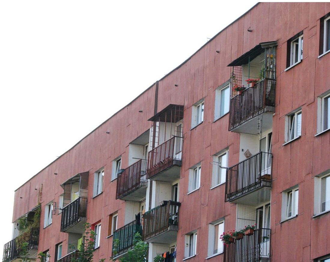
Fot.21. Widok części stropowej budynku od strony wschodniej (aut. Szymon Wójcik)
