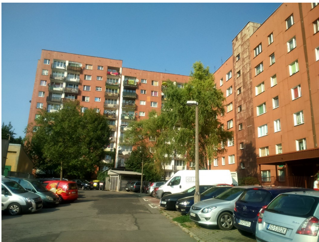
Fot.10. Widok budynku od strony zachodniej (aut. Szymon Wójcik)
