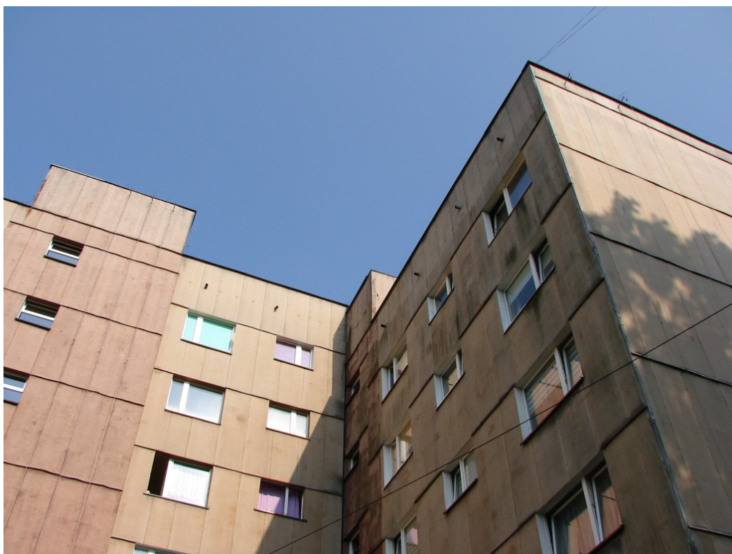
Fot.9. Widok budynku od strony południowej (aut. Szymon Wójcik)
