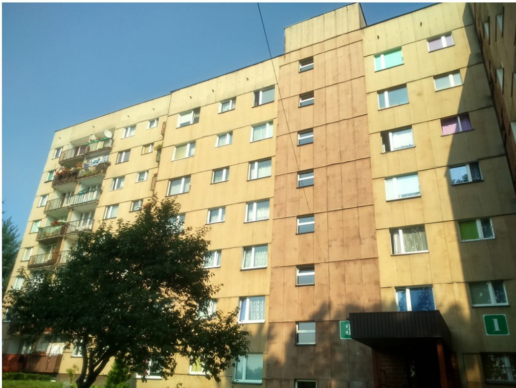
Fot.10. Widok budynku od strony południowej (aut. Szymon Wójcik)
