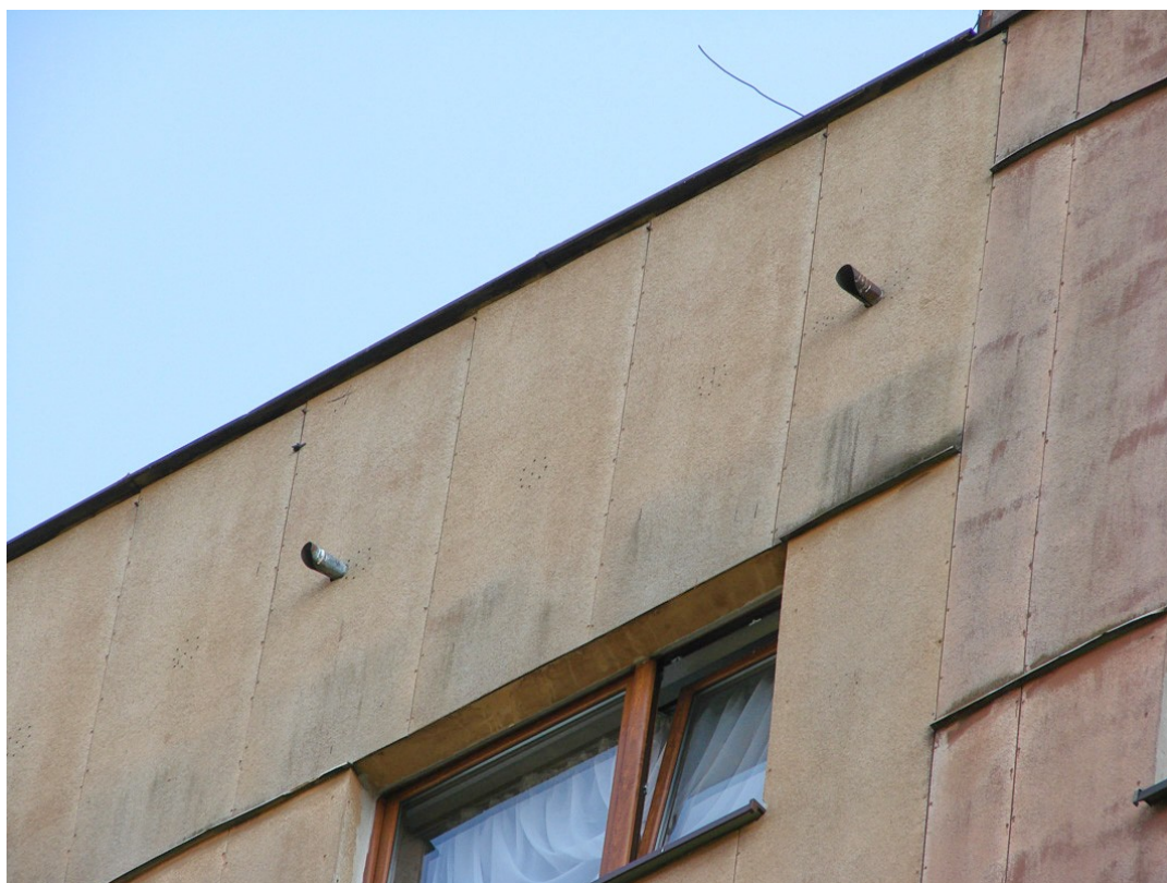
Fot.17. Widok części stropowej budynku od strony północnej (aut. Szymon Wójcik)
