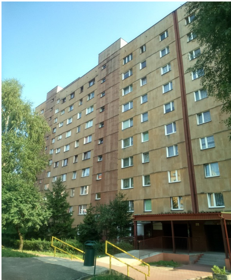
Fot.12. Widok budynku od strony zachodniej (aut. Szymon Wójcik)
