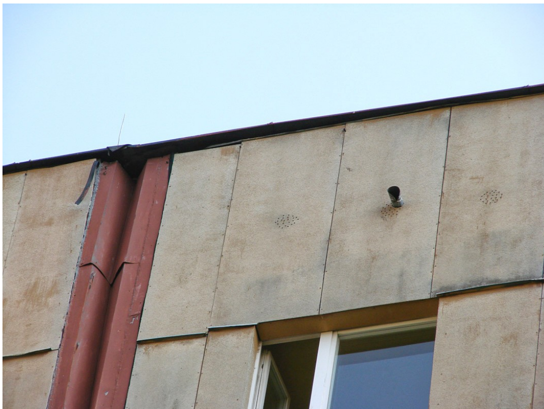
Fot.14. Widok części stropowej budynku od strony północnej (aut. Szymon Wójcik)
