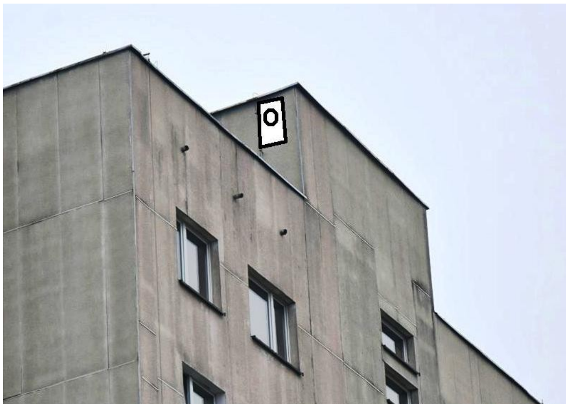
Fot.26. Miejsce montażu budek dla kawki w zbliżeniu. Budki mogą być nieco bardziej odsunięte od krawędzi ściany w głąb dachu (aut. Szymon Wójcik)
