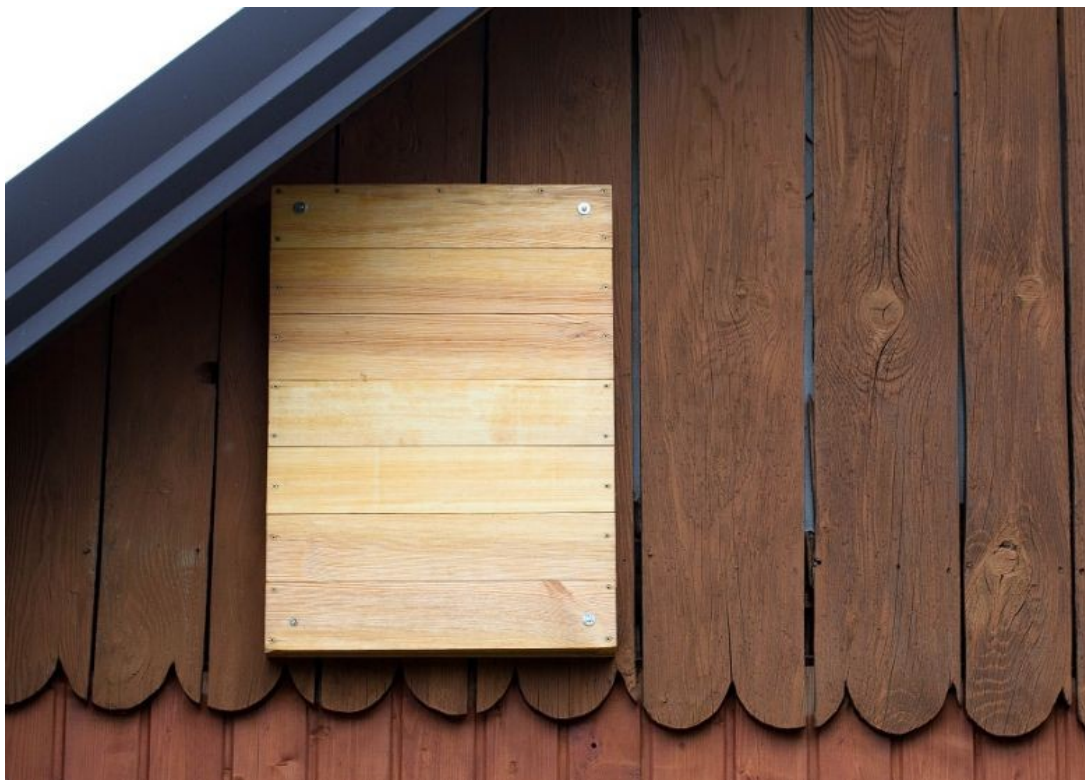
Fot.30. Przykładowa budka natynkowa. Po zamocowaniu budki należy ją pokryć styropianem zostawiając otwór wlotowy (aut. Szymon Wójcik).
