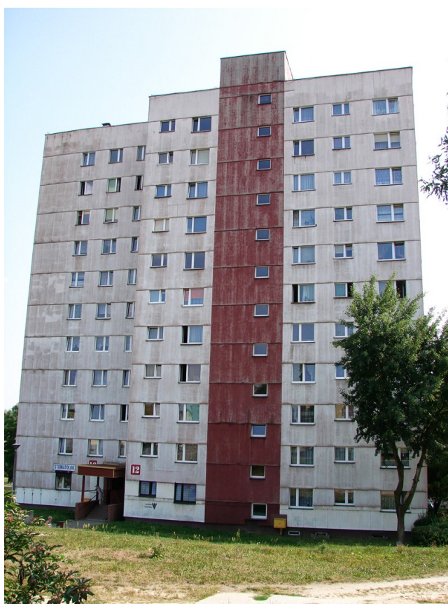
Fot.13. Widok budynku od strony północnej (aut. Szymon Wójcik)
