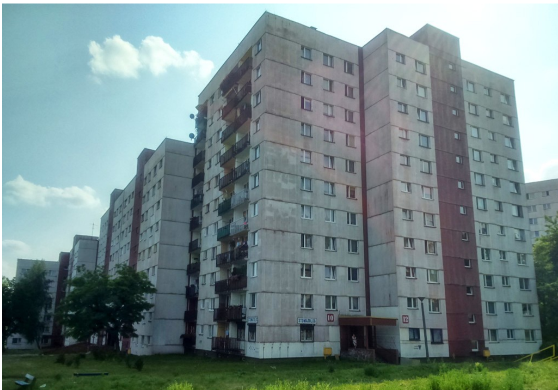
Fot.16. Widok budynku od strony pn-wsch (aut. Szymon Wójcik)
