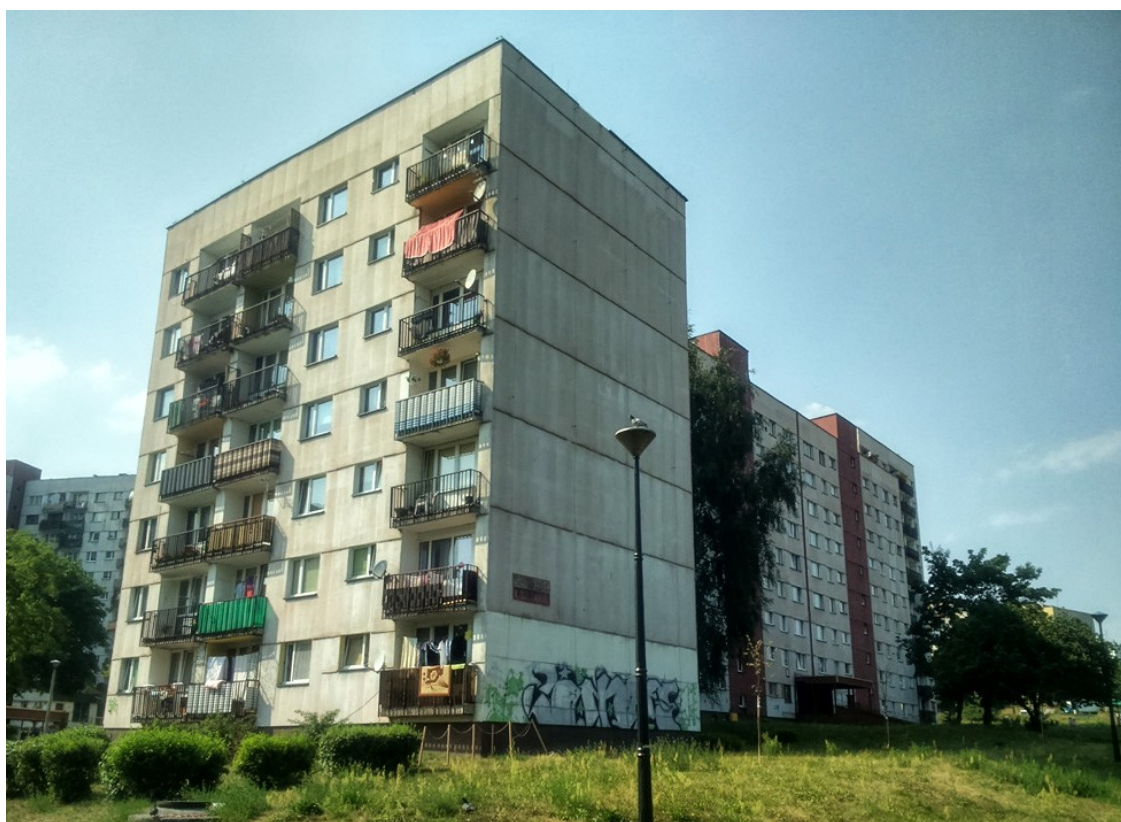
Fot.21. Widok budynku od strony pd-wsch (aut. Szymon Wójcik)
