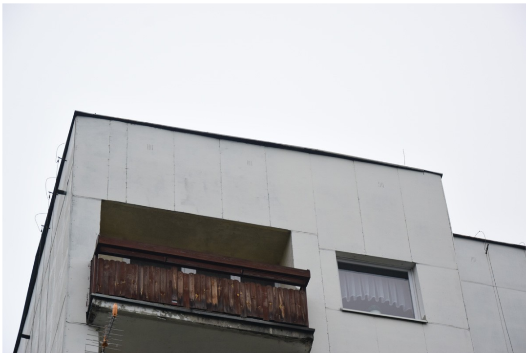
Fot.13. Widok części stropowej od strony południowej (aut. Szymon Wójcik)
