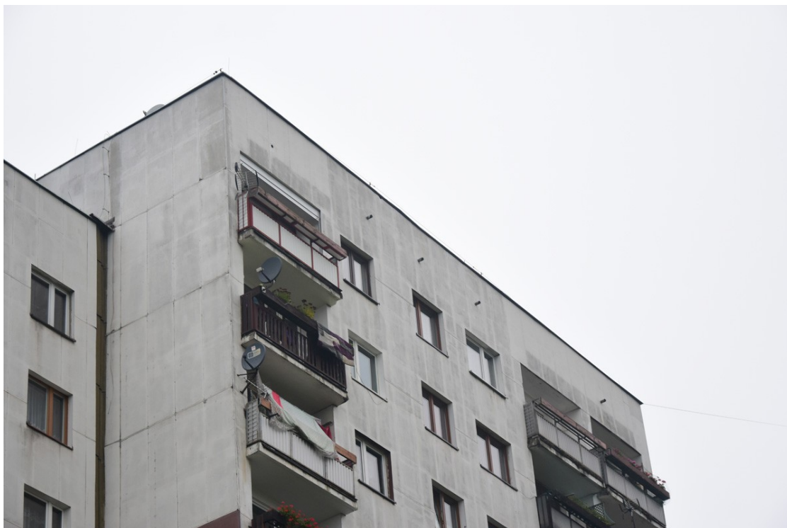
Fot.17. Widok części stropowej budynku od strony wschodniej (aut. Szymon Wójcik)
