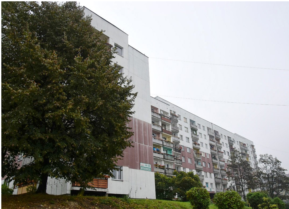
Fot.11. Widok budynku od strony południowej (aut. Szymon Wójcik)
