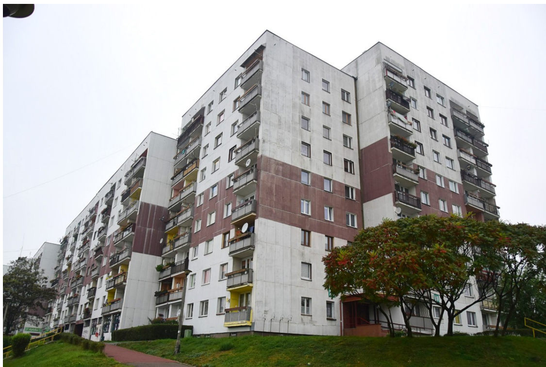
Fot.16. Widok budynku od strony pd-wsch (aut. Szymon Wójcik)
