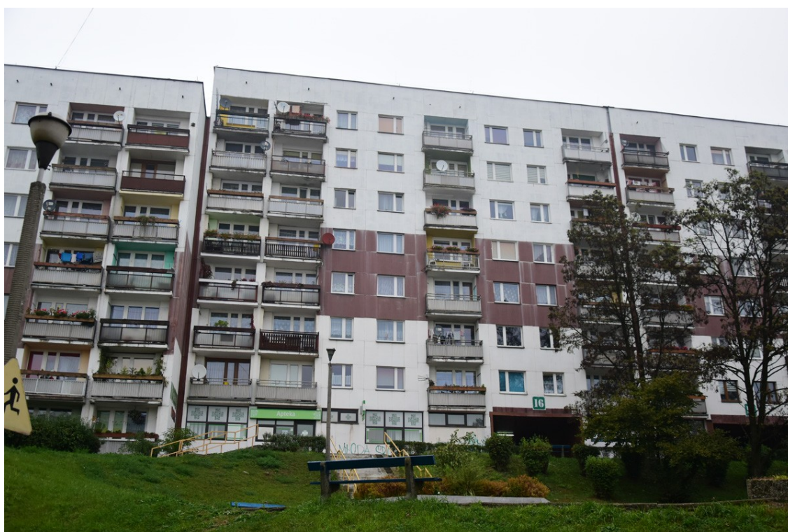
Fot.14. Widok budynku od strony południowej (aut. Szymon Wójcik)
