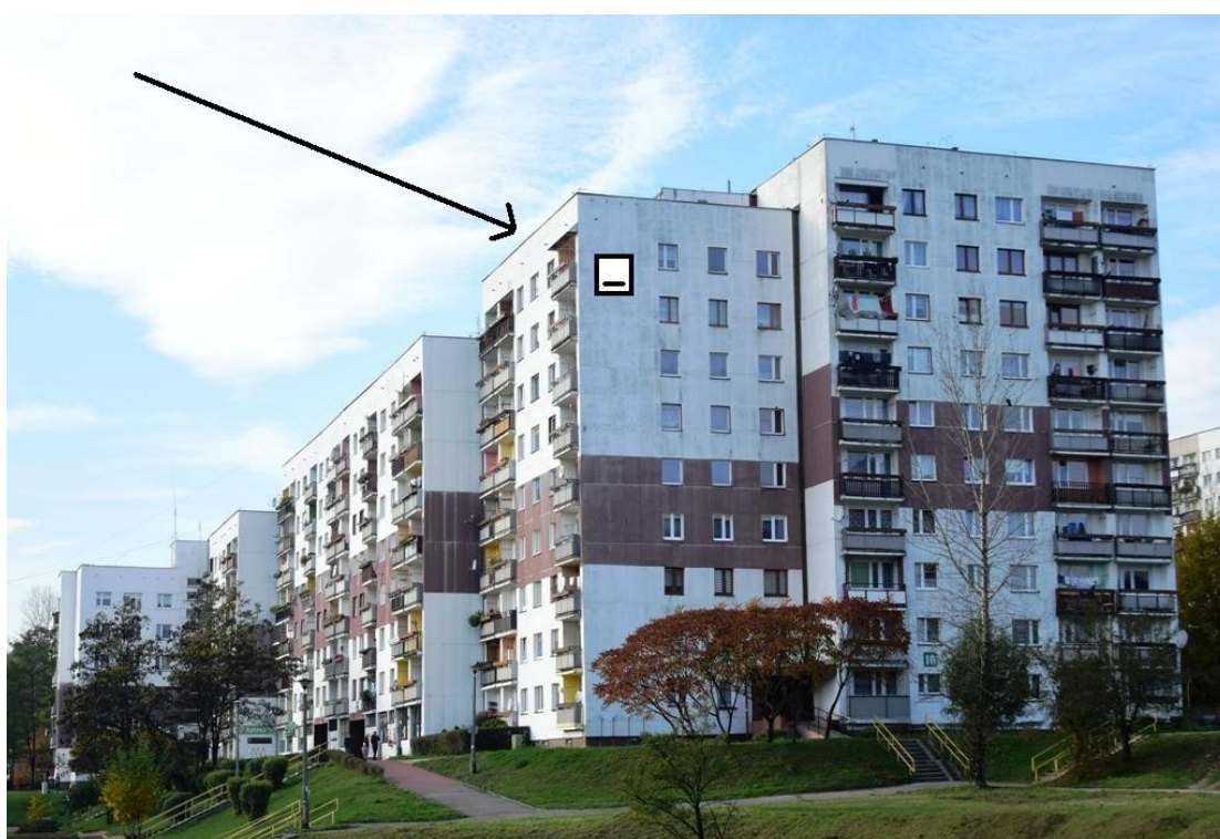
Fot.22. Zalecane miejsce montażu budki podtynkowej dla nietoperzy (aut. Szymon Wójcik)
