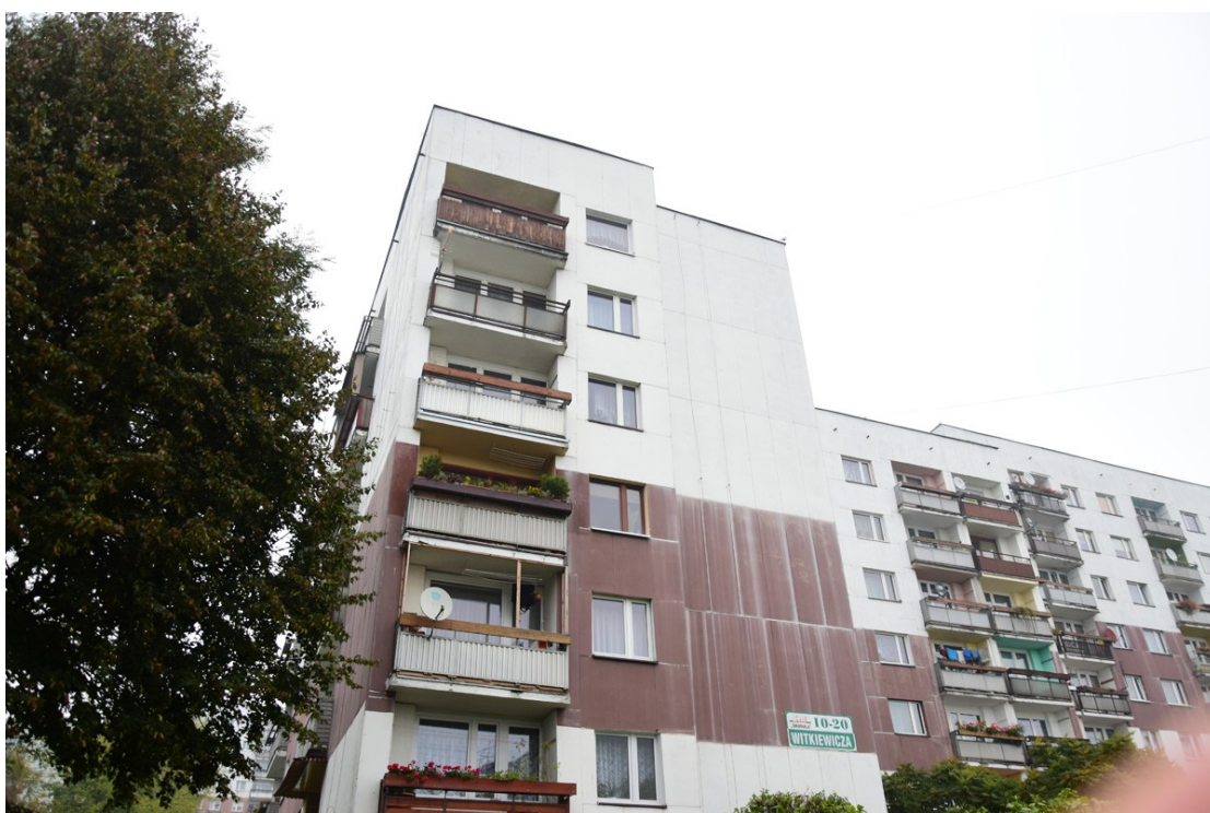
Fot.12. Widok budynku od strony południowej (aut. Szymon Wójcik)
