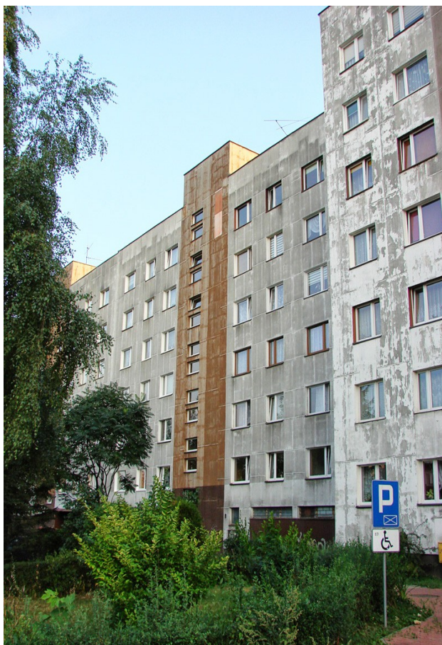
Fot.6. Widok budynku od strony północnej (aut. Szymon Wójcik)
