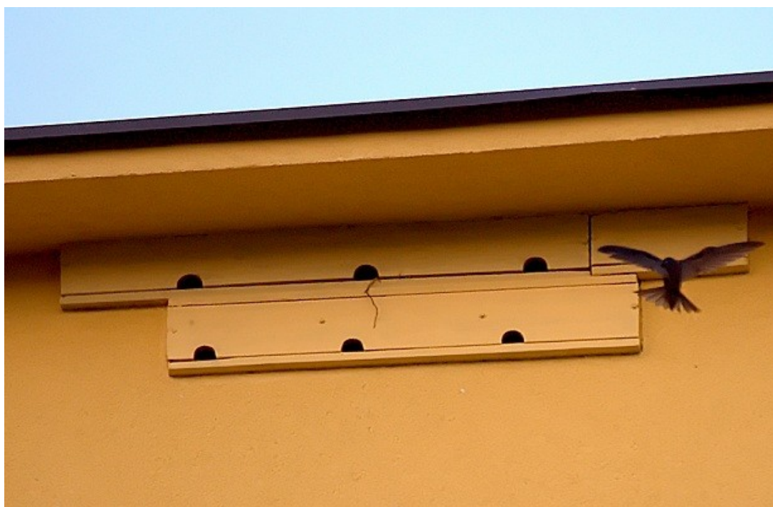
Fot. 24. Efekt końcowy – budka dla jerzyka Apus apus otoczona styropianem (aut. Szymon Wójcik)
