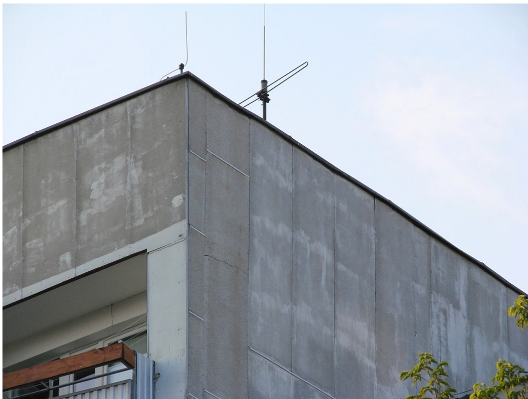
Fot.15. Widok części stropowej budynku od strony wschodniej (aut. Szymon Wójcik)
