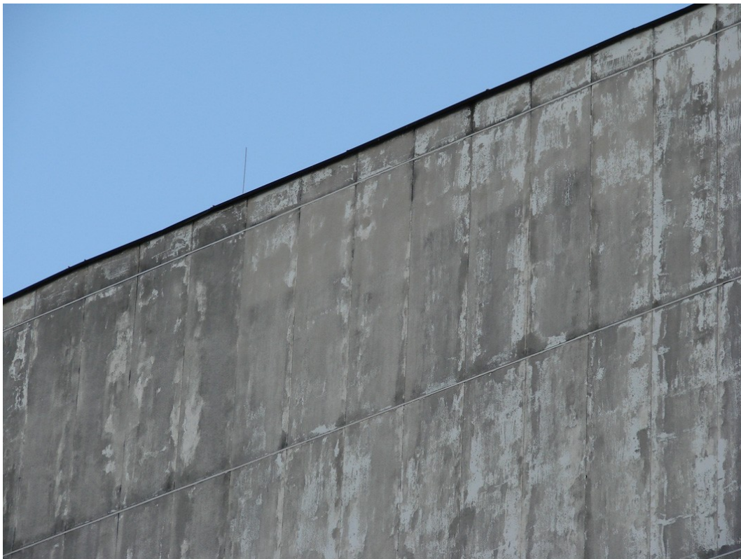
Fot.3. Widok części stropowej od strony północnej (aut. Szymon Wójcik)
