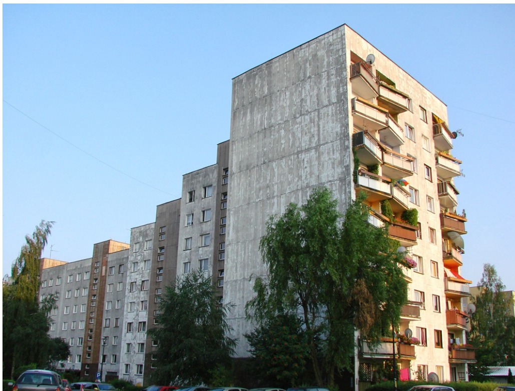
Fot.1. Widok części stropowej od strony północnej (aut. Szymon Wójcik)
