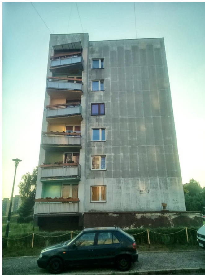
Fot.14. Widok budynku od strony wschodniej (aut. Szymon Wójcik)
