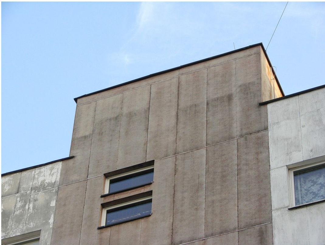
Fot.7. Widok części stropowej od strony północnej (aut. Szymon Wójcik)
