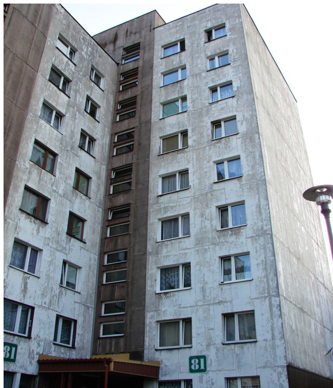
Fot.5. Widok budynku od strony północnej (aut. Szymon Wójcik)
