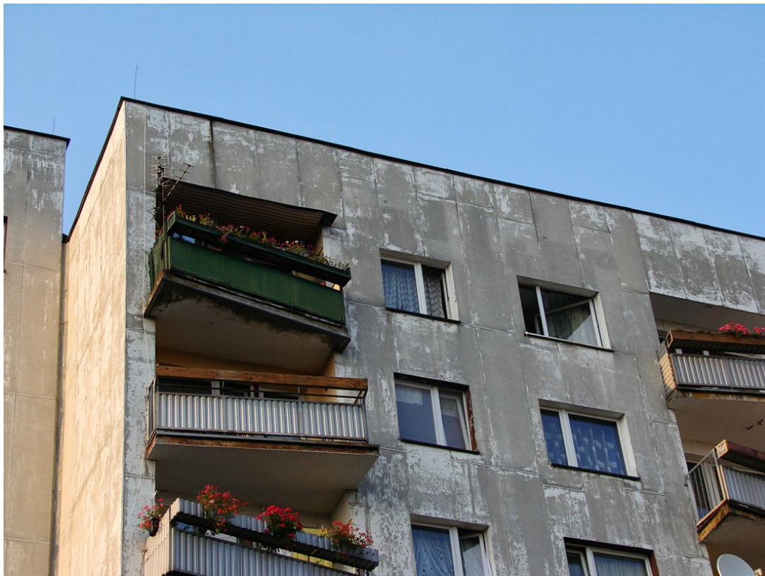
Fot.19. Widok części stropowej budynku od strony południowej (aut. Szymon Wójcik)
