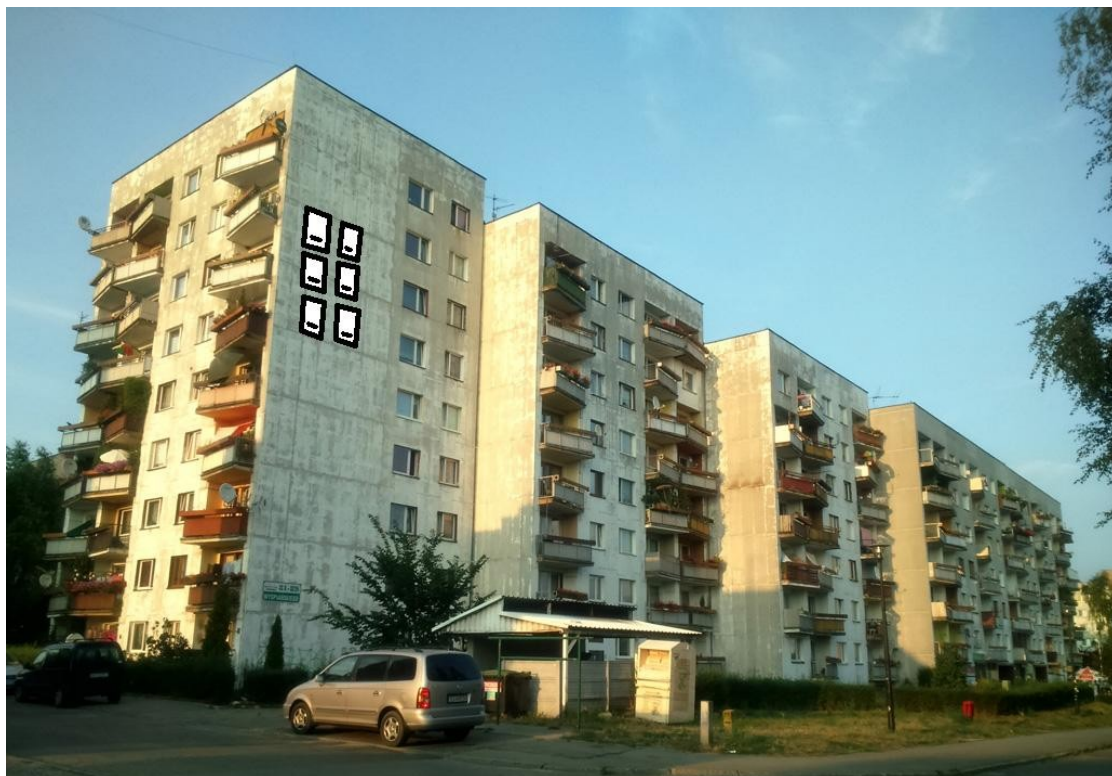
Fot.21. Zalecane miejsce montażu skupiska 6 budek podtynkowych dla nietoperzy od strony południowej (aut. Szymon Wójcik)
