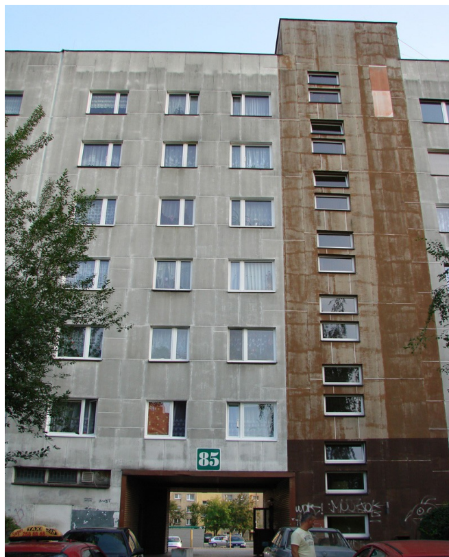
Fot.9. Widok budynku od strony północnej (aut. Szymon Wójcik)
