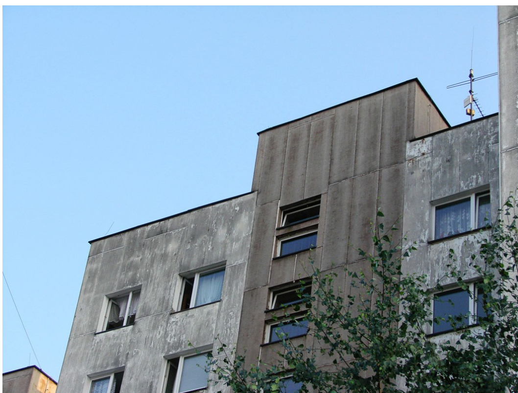
Fot.4. Widok części stropowej od strony północnej (aut. Szymon Wójcik)
